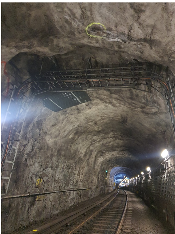
Transportsträcka till plattform.
